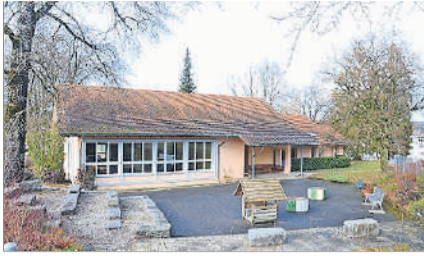
Sanierung notwendig: Schulhort.
