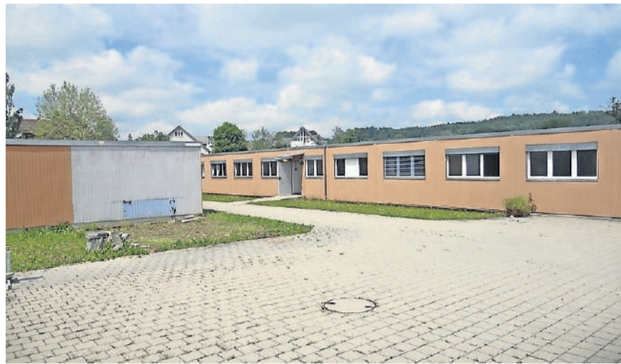
Die Asylunterkunft muss weichen und wird abgebrochen.
