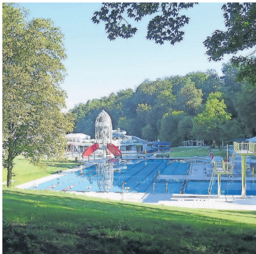
Das Freibad Schluefweg wurde für knapp 13 Millionen saniert. Foto: zvg.
